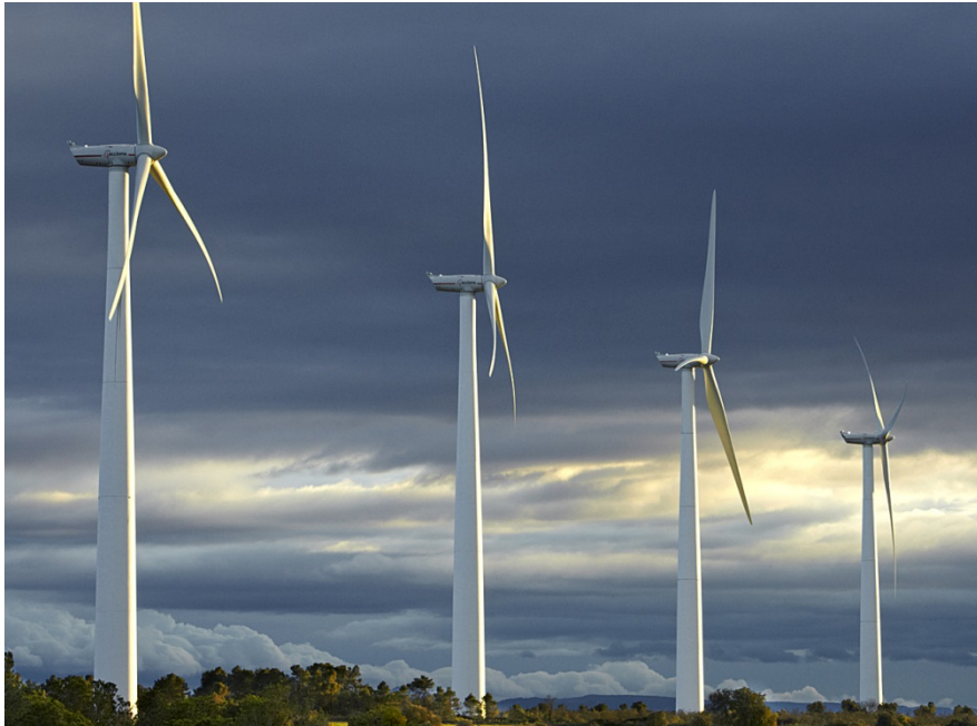
Potencia eólica instalada en Chile y perspectivas (MW)
