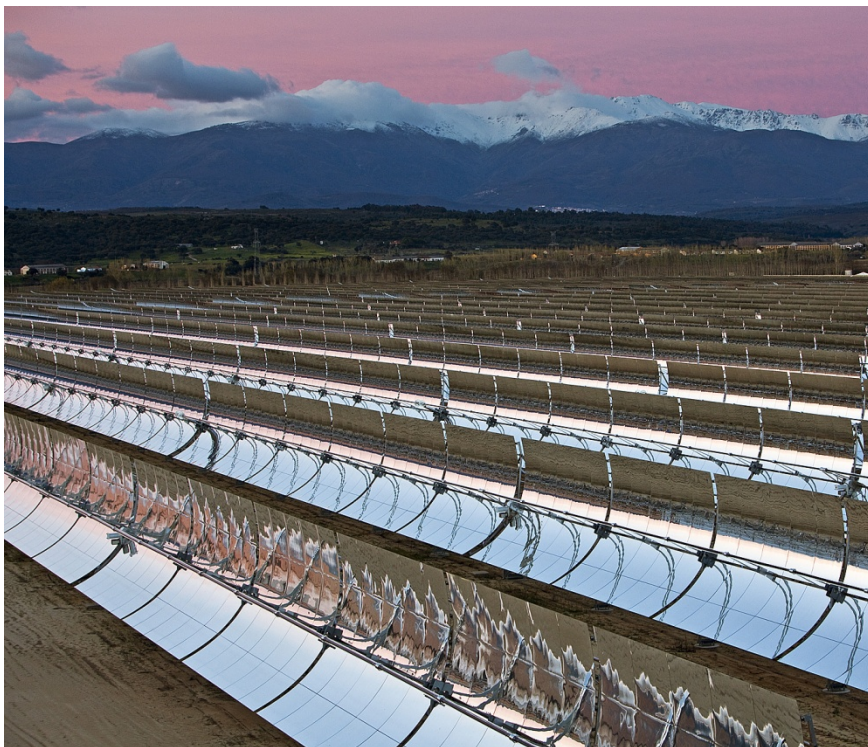
► Planta termosolar cilindro-parabólica
