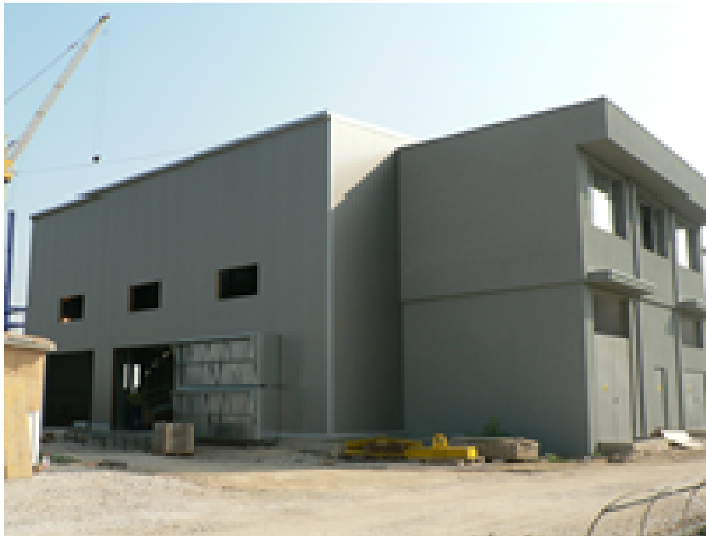
Edificio Principal de co-generación de la planta de Karlovo
