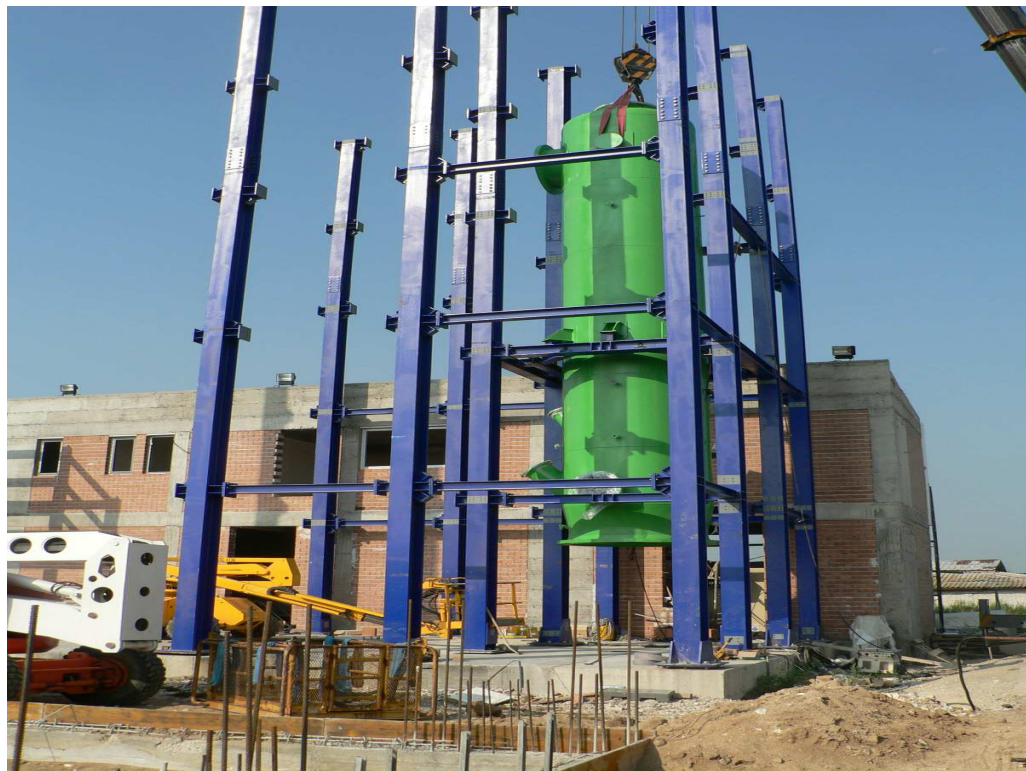
Instalación del Gasificador de la planta de Karlovo
